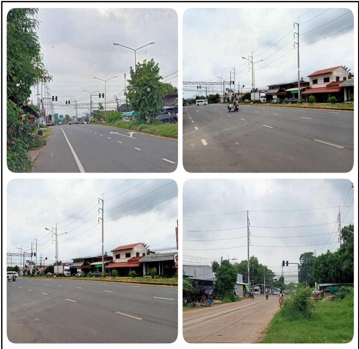
ภาพที่ ๓.๑๓ สภาพถนนบริเวณทางหลวงเส้น ๒๓๗๐ ถนนนิคมคำสร้อย-หนองสูง อ.นิคมคำสร้อย
