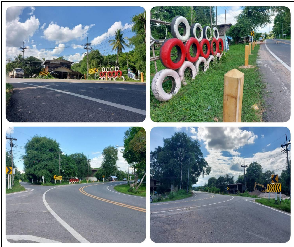
ภาพที่ ๓.๗ สภาพถนนบริเวณทางแยกโค้งบ้านน้ำบ่อ ต.หนองบัว อ.ดงหลวง
