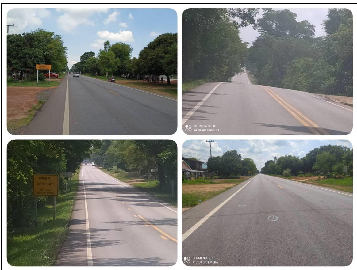
ภาพที่ ๓.๘ สภาพถนนบริเวณระหว่าง บ.โนนยาง-บ.จิว ต.โนนยาง อ.หนองสูง
